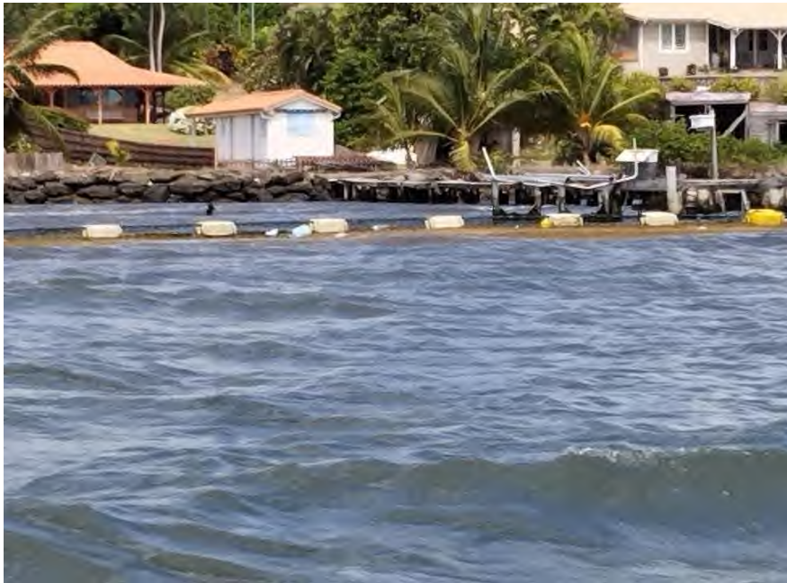
Photo n° 1 : barrage de Cap-Est
